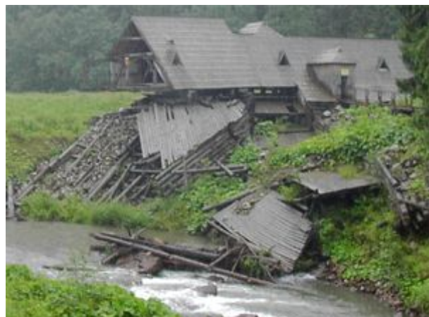
múzeum pltníctva poškodené povodňou
